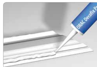
Påfør monteringslim på skinnen og taklisten
